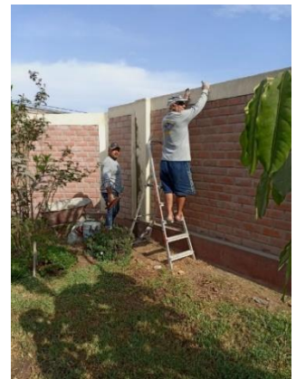
(園庭外壁の補修の様子)
